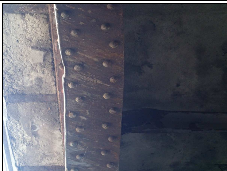
Foto č. 6 – konstrukce K 01 – nad O 01 – příčná výztuha – deformace, přetržení
