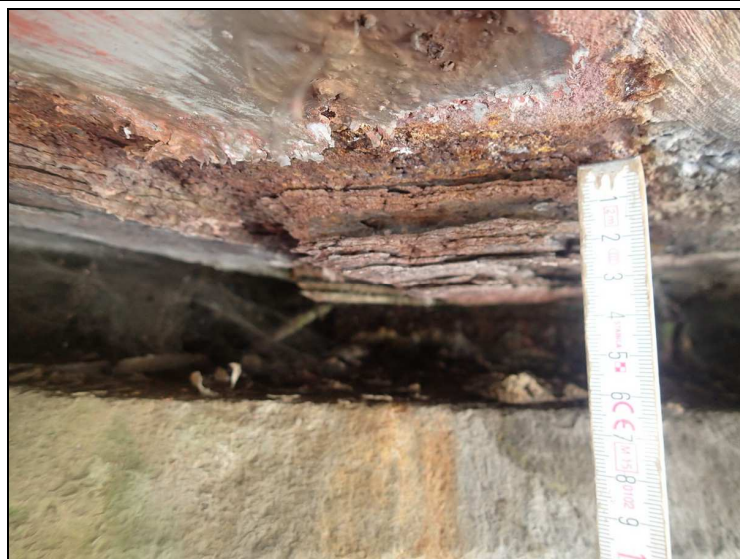
Foto č. 4 – konstrukce K 01 – nad O 01 – 11. nosník – korozní oslabení
