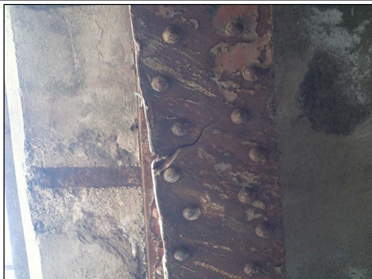
Foto č. 5 – konstrukce K 01 – chodníkový nosník vlevo – deformace, trhлина
