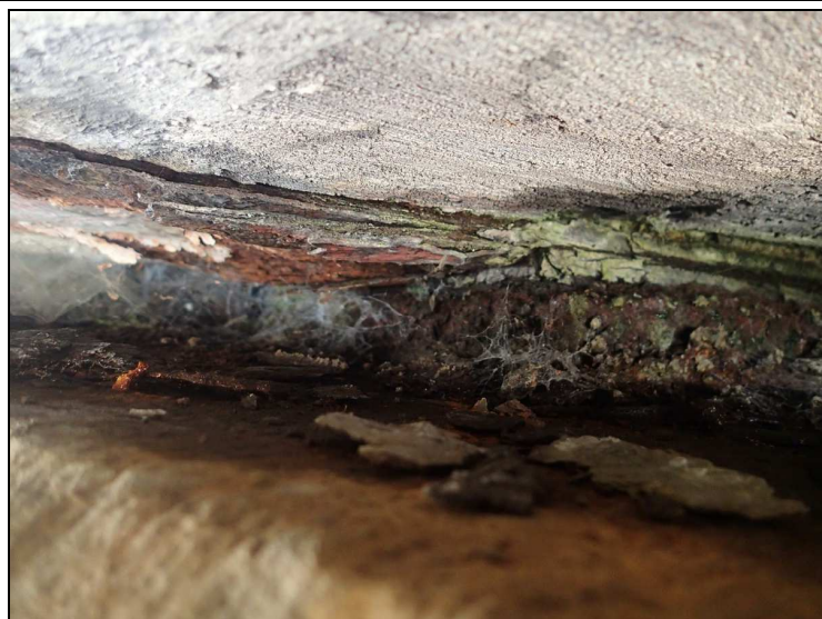
Foto č. 2 – konstrukce K 01 – nad O 01 – 10. nosník – korozní oslabení
