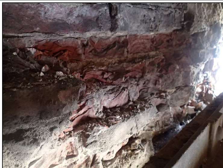
Foto č. 8 – opěra O 01 – závěrné zdivo vlevo – vydrolení, rozvolnění
