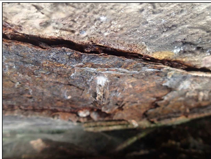
Foto č. 1 – konstrukce K 01 – nad O 01 – 1. nosník – korozní oslabení
