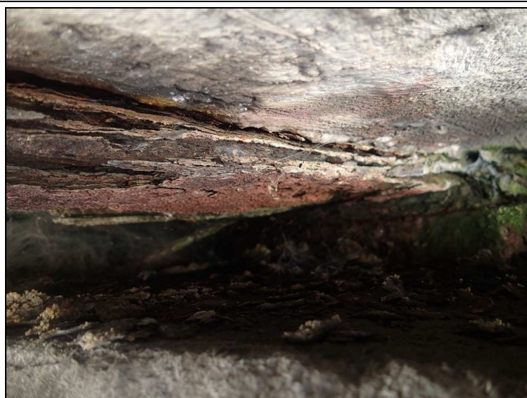
Foto č. 3 – konstrukce K 01 – nad O 01 – 11. nosník – korozní oslabení
