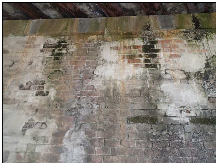
Foto č. 7 – opěra O 01 – průsaky vody a pojiva
